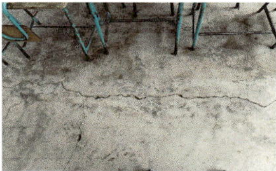
Foto 5: Sustrucción de Pisos en mal estado.
